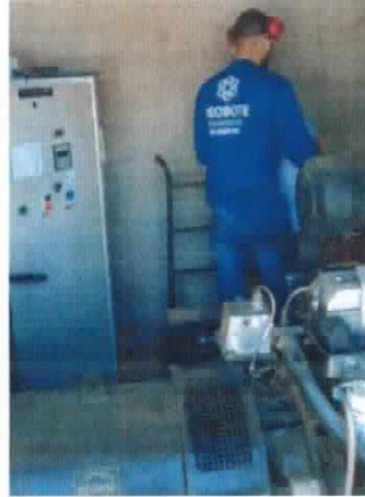
Figura 3. Manutenção Gerador - REOBOTE
