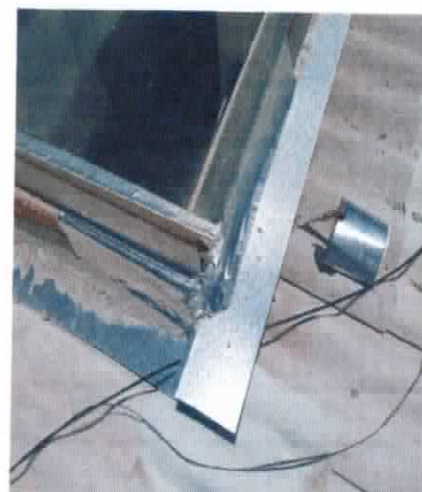
Figura 2. Troca de telhas
