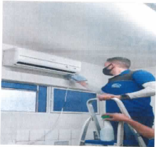
Figura 1 Manutenção ar condicionado
