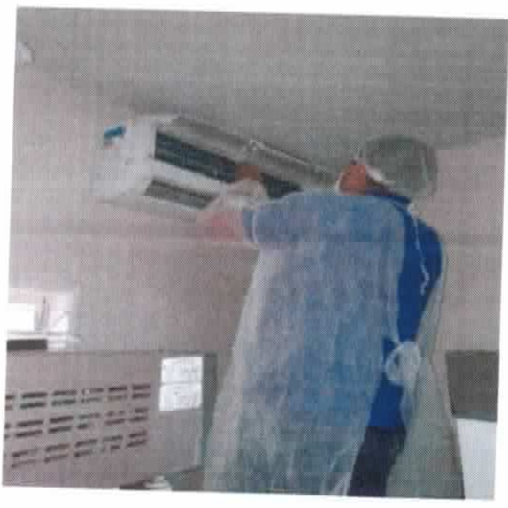
Figura 1 . Manutenção Ar condicionado
