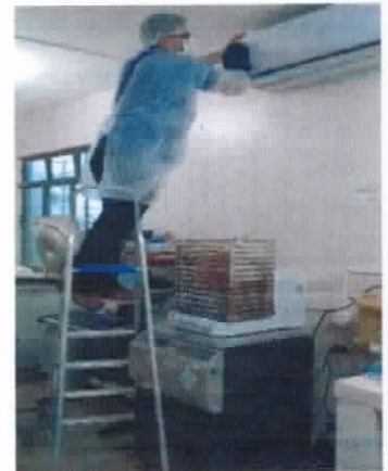
Figura 4. Manutenção ar condicionado
