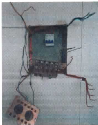
Figura 5. Manutenção Corretiva Elétrica
