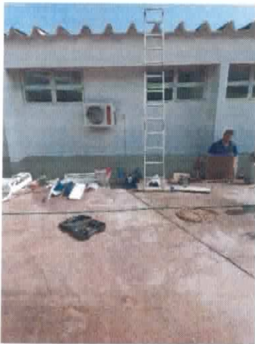
Figura 4. Manutenção do ar condicionado
