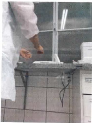
Figura 1. Instalação de tomadas
